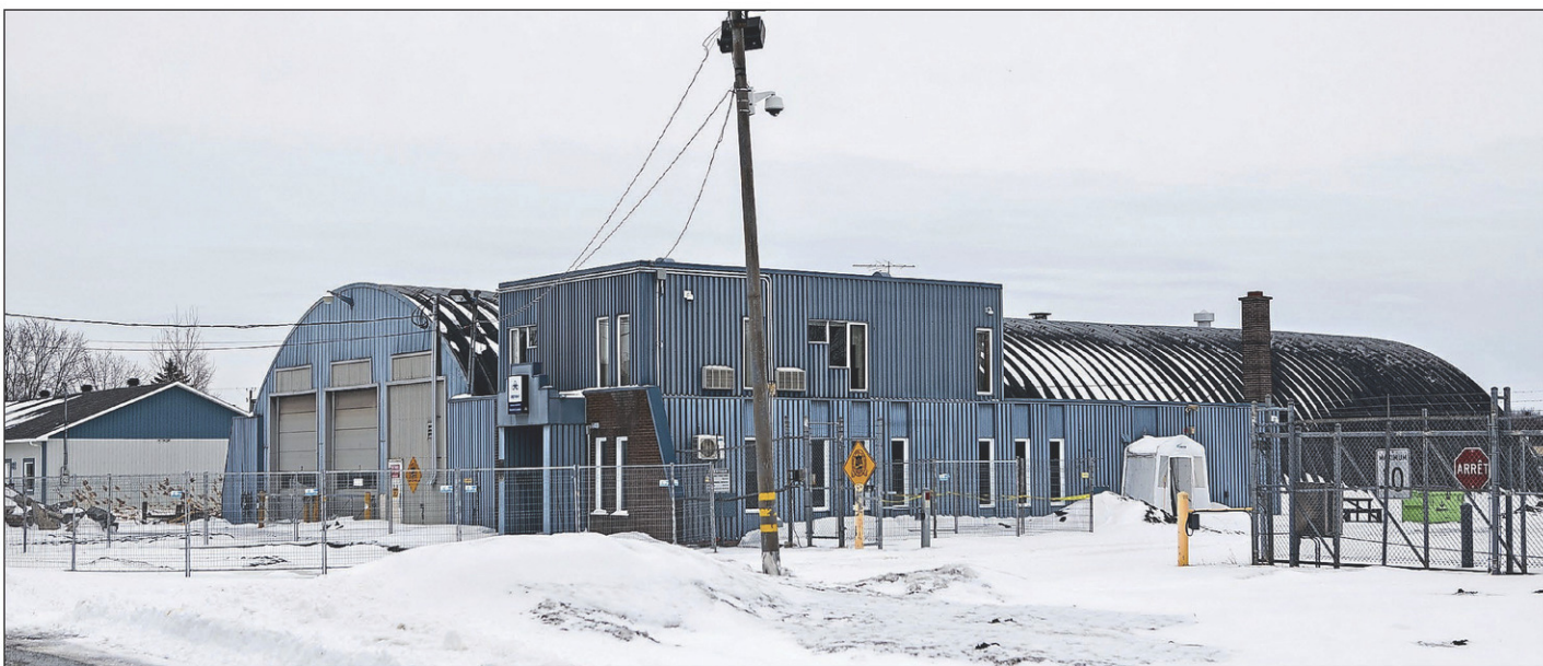
Ce bâtiment, situé sur un vaste lot de 187 000 pieds carrés dans le secteur Saint-Athanase Sud, fait l'objet d'une demande de démolition.
