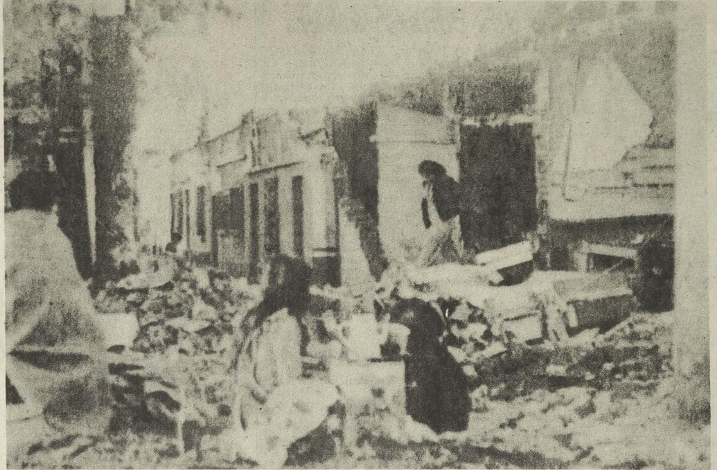
Les habitants de Guatemala City ne peuvent faire autrement que de s'installer dans la rue après la destruction de leur maison. La ville même a été rasée à 80%.
