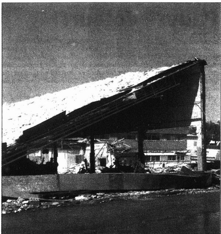
Le gymnase a été le premier à subir les travaux de démantèlement.
