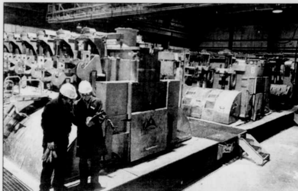
◆ Au milieu des années 1970, des visionnaires ont entrepris de démontrer la possibilité de réaliser des cuves fonctionnant à près de 300 000 ampères. C'est à cette période que débuta donc le développement des cuves expérimentales Apex.
