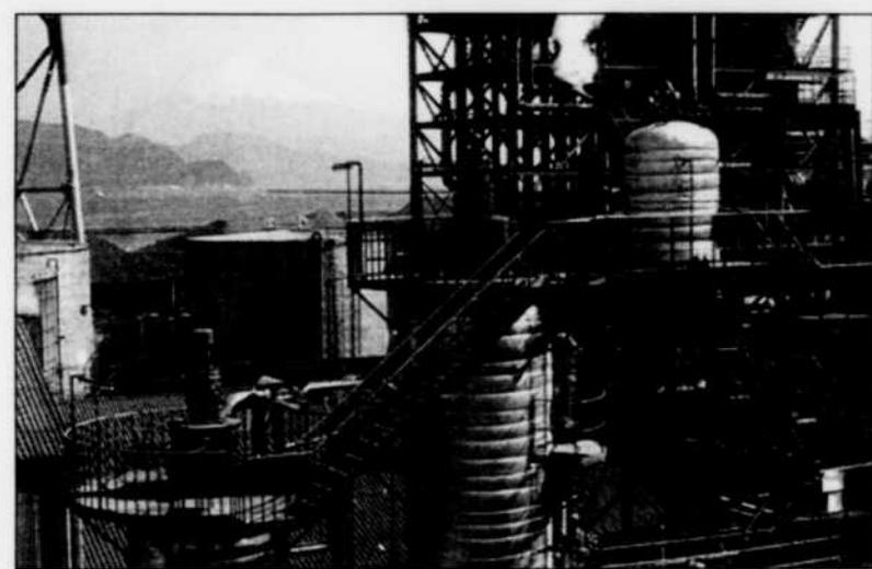
◇ Le décanteur sous pression à l'Usine Shimizu située au Japon.
