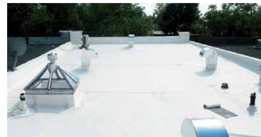
La différence de température entre une toiture foncée et une toiture claire peut varier de 15 à 20°C.
