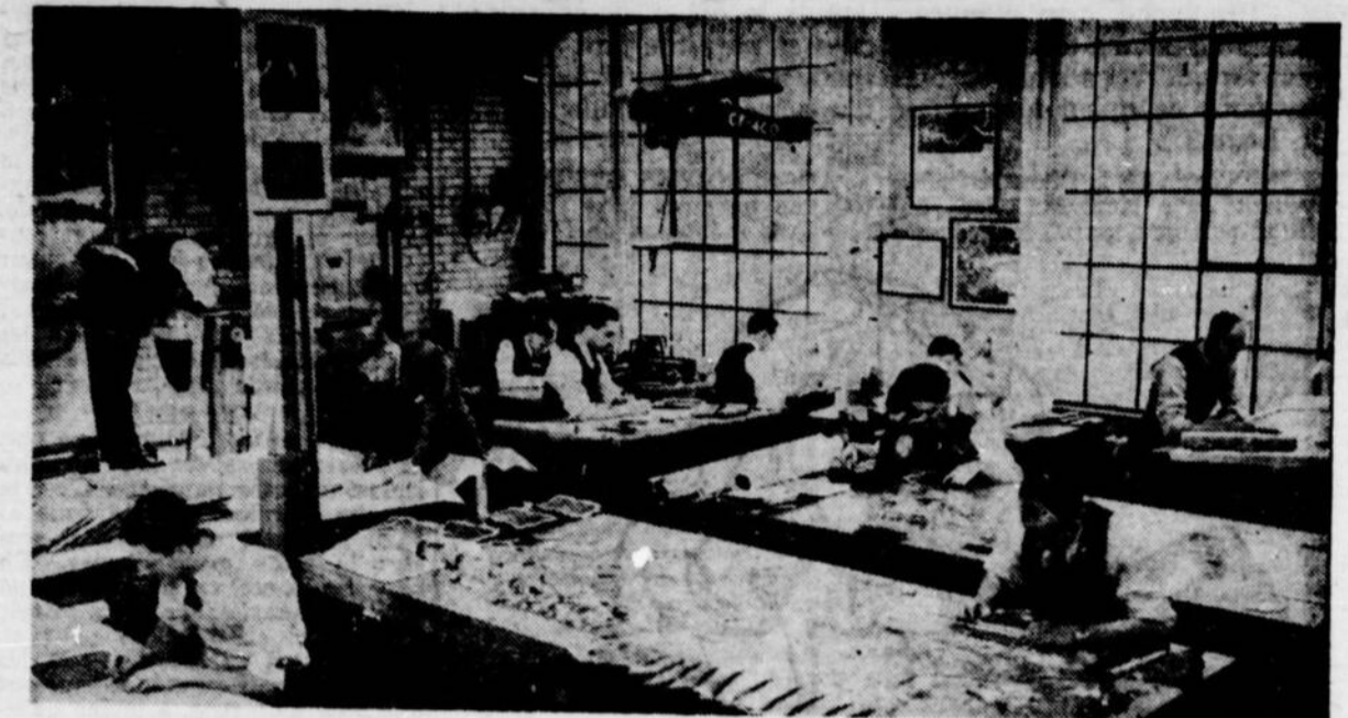
Les arpenteurs-dessinateurs assemblent des photos aériennes afin de former une mosaïque de la région dont ils ont à dresser la carte. Voici des tables de huit pieds par quatre sur lesquelles ils ont à compléter à l'échelle leur "jig-saw puzzle" moderne. — (Photo du "Petit Journal").
