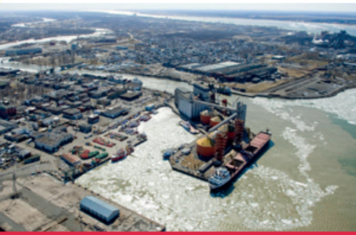
LE PORT DE SOREL-TRACY ET LES INSTALLATIONS DE RICHARDSON EN 2007
