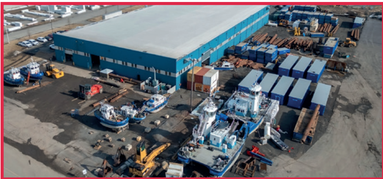
INSTALLATIONS DE GROUPE OCÉAN À SOREL-TRACY, DANS LE PARC INDUSTRIEL LUDGER-SIMARD
