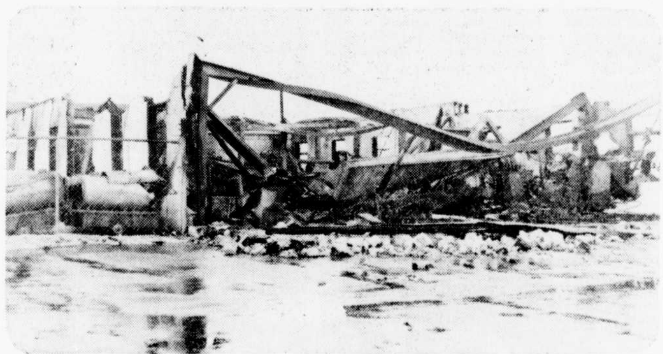
Perco Ltée, de la rue Girard, à Trois-Rivières a été complètement détruit, dans la nuit de jeudi à vendredi par un incendie. Les pertes matérielles at-
