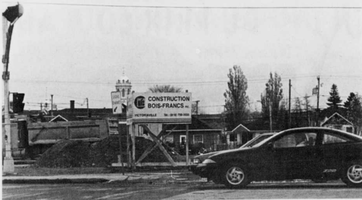
CONSTRUCTION - L'entrepreneur Construction Bois-Francis érigera la bâtisse de la nouvelle pharmacie Jean Coutu de Roberval.
