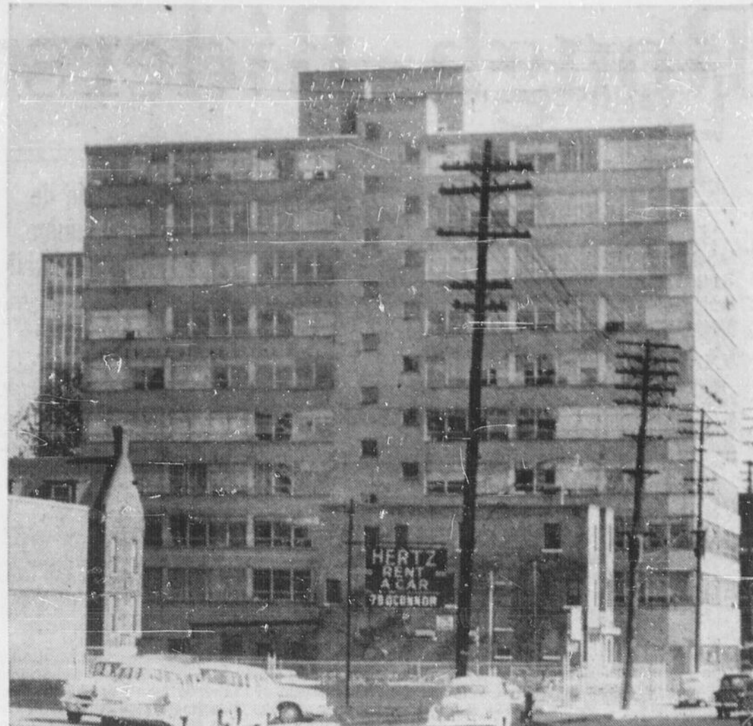
LA RUE SLATER, angle nord-est d'O'Connor, est bien "garnie" de vieux poteaux et d'innombrables fils électriques et téléphoniques
