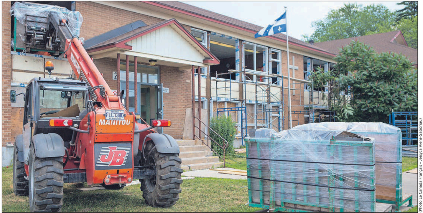
Plusieurs travaux sont en cours à l'édifice Sacré-Cœur de l'école des Savanes, qui a obtenu une cote E «très mauvais» relativement à son état de dégradation.
