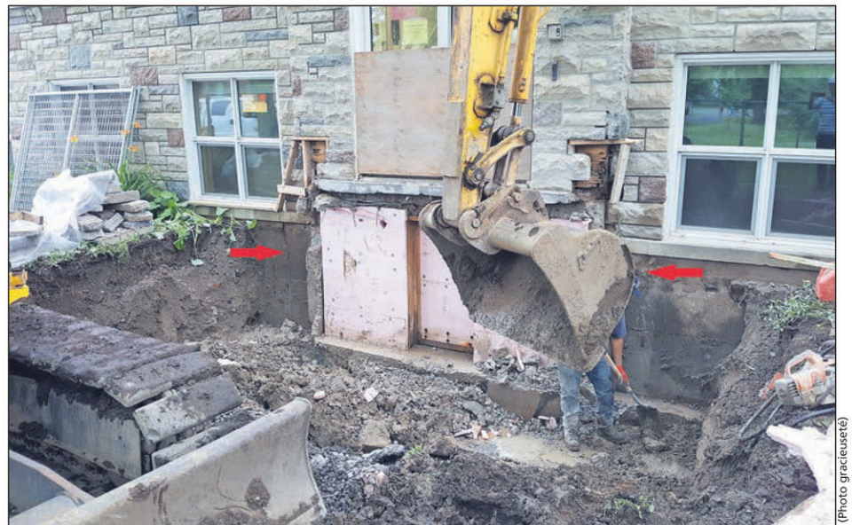
Travaux de réfection des fondations à l'édifice Docteur-Poulin de l'école de La Relance, à Marieville.
