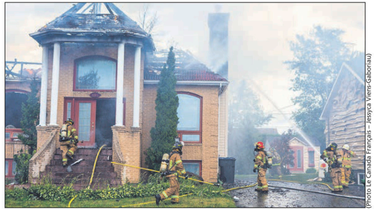
La maison de la rue Augustin-Gauthier est une perte totale.
