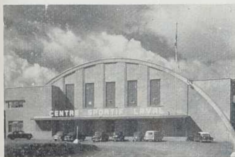
Détail de la façade.
