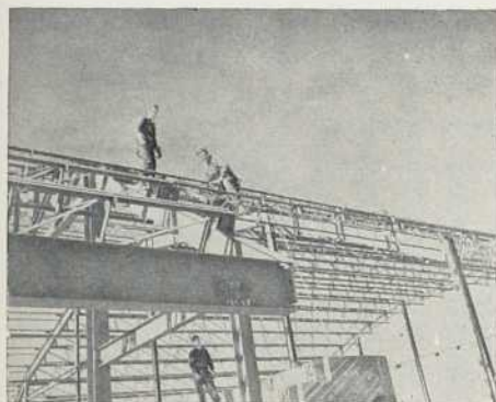
Les poutrelles d'acier sont boulonnées aux cadres.
