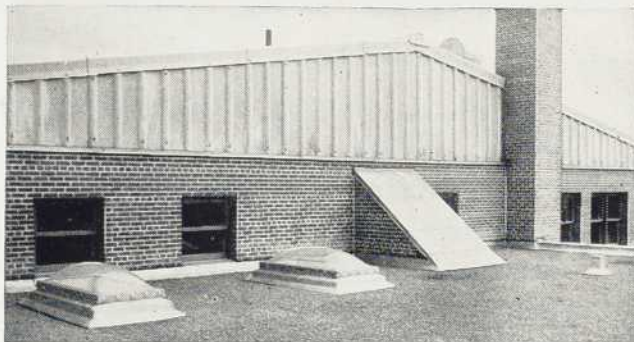
On a fait en Monel les lanterneaux et les rejeteaux du nouvel édifice de la compagnie Robert W. Bartram Limited, de Montréal. Entrepreneurs: H. B. Beloff Roofing Company, Montréal, P.Q.
