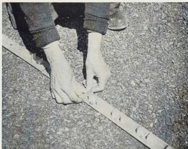
Installation des pièces de métal qui supporteront la tuyauterie. Elles reposent sur une couche de sable.
