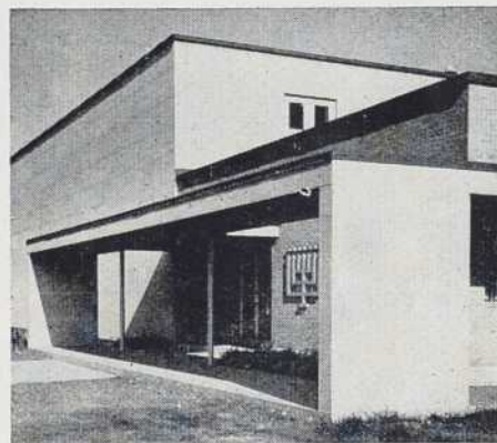
Détail de l'entrée principale.
