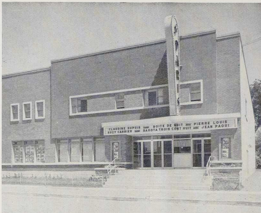
Immeuble très simple, pratique et peu coûteux. En bas, détail de l'entrée.
