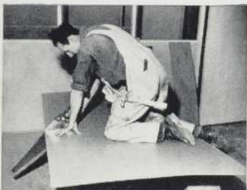
LE SCIAGE avec une scie ordinaire donne des bords propres et nets, sans éclats ni cassures.
