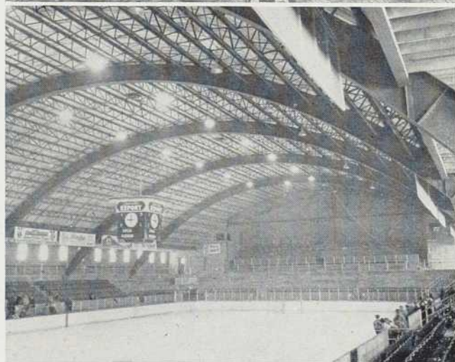
Deux vues d'ensemble de l'œuvre terminée. Six cadres rigides en acier placés à 36'-4" de centre en centre forment l'ossature principale de la toiture de la patinoire.
