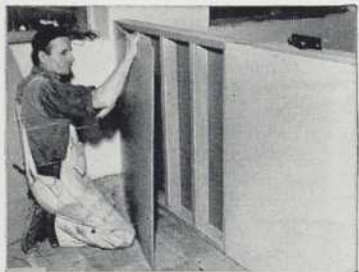
LA POSE est des plus faciles: on employa ici des clous à finir de 1 1/4" plantés à 6" d'intervalle sur des colombages espacés de 12" (centre à centre). La plupart des cloisons ont 7' de hauteur et se terminent par des vitres allant jusqu'au plafond.
