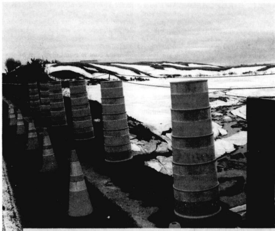
Le garde-fou a été arraché sur plusieurs mètres. (Photo: France Paradis)
