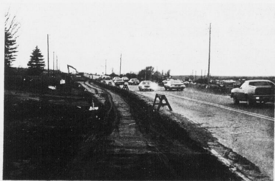
Des réparations récentes sur la route 116 à la hauteur de la sortie vers Princeville ont donné lieu à d'importants travaux d'élargissement...avec les inconvénients qui en résultent.
