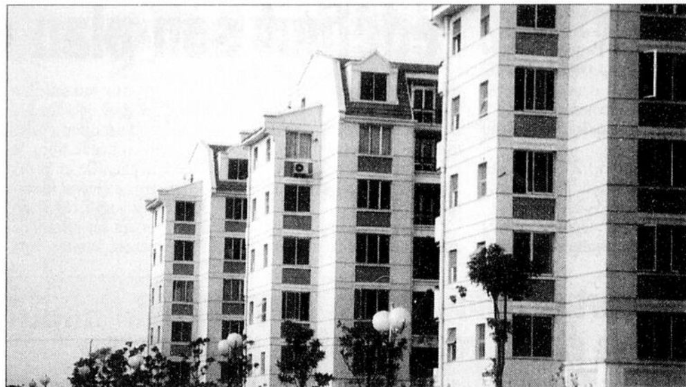
■ Nouveaux immeubles à loyer modique du quartier Pudong, près de Shanghai. Une compagnie canadienne doit y construire, à l'automne 1997, des immeubles de démonstration dans le cadre d'un projet sino-canadien.
