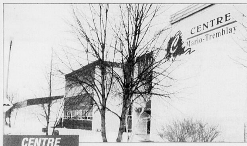
CENTRE La toiture du centre sportif nécessiterait des travaux évalués à 700 000 $.
