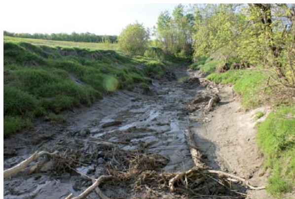
Figure 5.1 Photographie du lit asséché de la rivière Salvail, prise vers l'aval, à une cinquantaine de mètres en aval du glissement.
