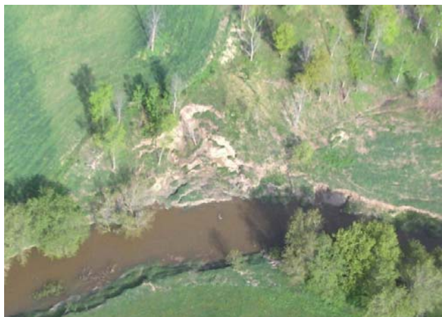
Figure 4.2 Photographie d'un glissement associé à un point d'érosion au niveau d'un méandre de la rivière Salvail.
