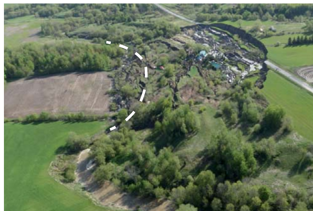
Figure 2.5 Lit de la rivière Salvail (ligne en pointillés blancs) complètement obstrué par les débris du glissement.
