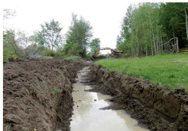
Figure 2.9 Canal creusé à l'extrémité des débris du glissement de manière à limiter la hausse du niveau d'eau en amont.
