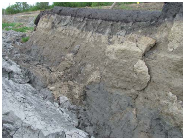
Figure 5.5 Photographie d'une tranche de terrain dans les débris, montrant l'unité A (en gris brunâtre) surmontée de la fondation de la route.
