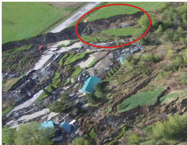
Figure 2.3 Importante tranche de sol (encadrée en rouge) qui s'est détachée de la paroi arrière du glissement durant la nuit du 10 au 11 mai 2010.
