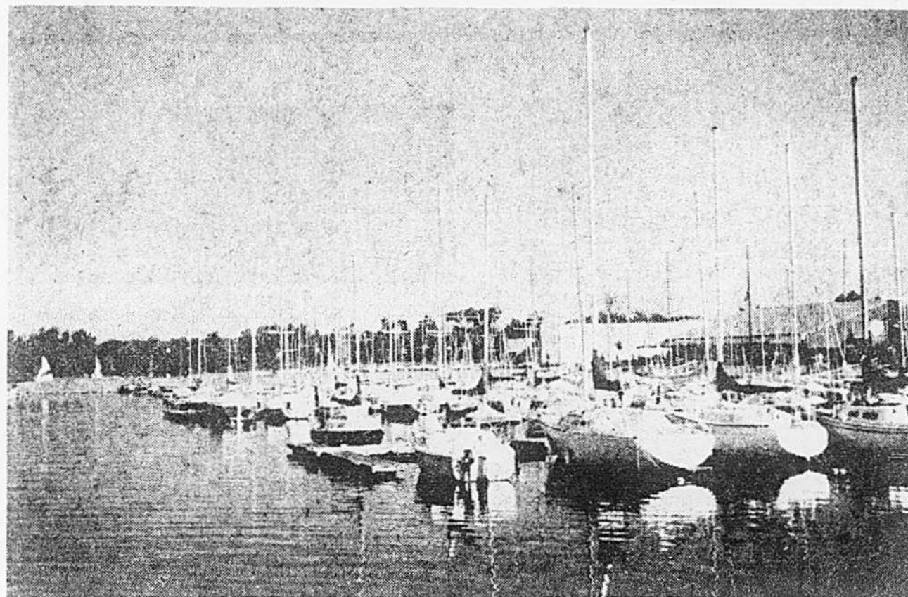
Une belle marina a été construite par la Société d'Aménagement de l'Outaouais, sur les bords du lac Deschênes, à Aylmer. Elle peut accueillir quelque 200 voiliers.
