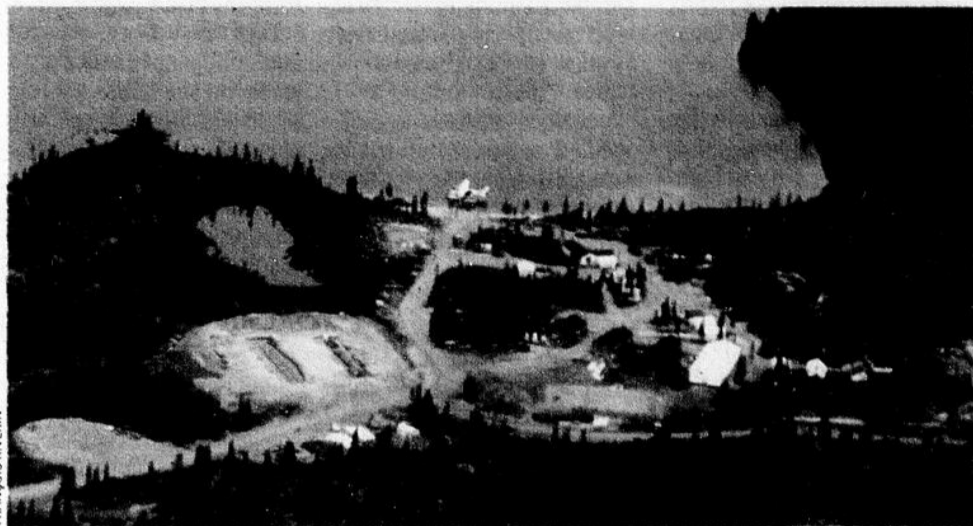
Le camp Lagopède accueille une soixantaine de personnes. Il comprend des unités de logement, des locaux de service et un mini-complexe industriel en construction.
