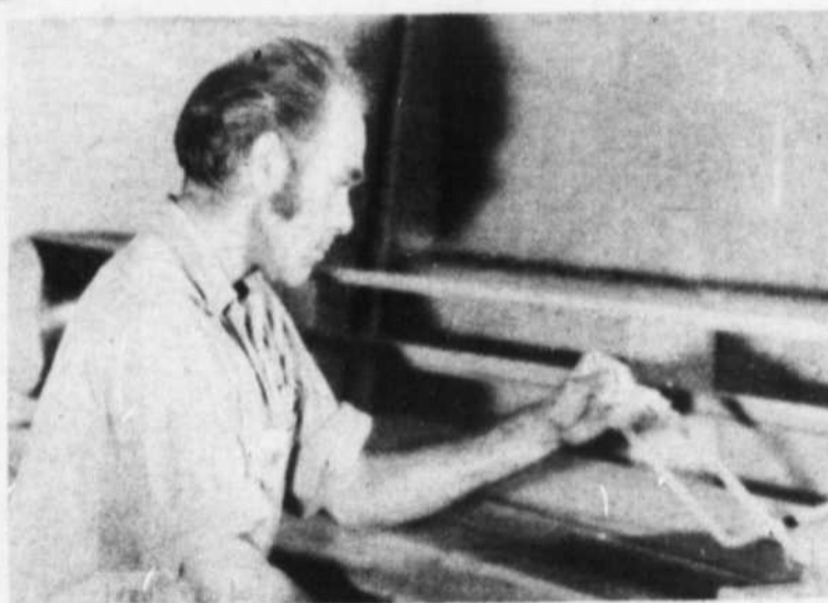
Emile Gariépy opère une sableuse à courroie horizontale.
