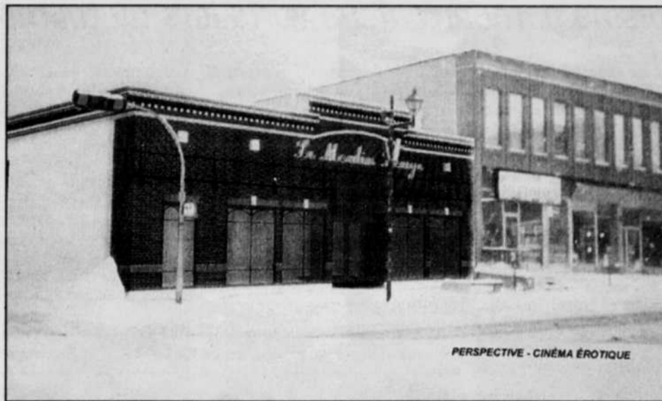
Le futur complexe XXX, dont on voit ici les plans de la façade, sera aménagé dans les locaux que le magasin de chaussures Yellow laissera vacants à la fin de la semaine. photo Michel Saint-Jean
