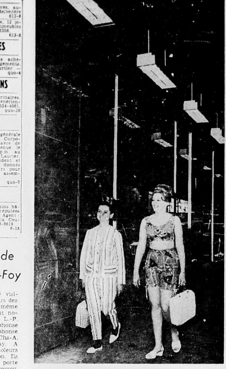
CETTE SCÈNE A ÉTÉ CROQUÉE HIER MATIN devant le magasin Pollack, où une installation de lampes infra-rouges dégage une chaleur suffisante pour faire fondre neige et glace et rendre l'emplacement immédiat assez chaud pour être confortable. La nouvelle installation, qui est située sur la rue St-Joseph et le boulevard Charest, mesure 330 pieds et est ainsi la plus longue jamais vue en Amérique du Nord. Chaque lampe infra-rouge dégage une intensité de 7.6 kilowatts.
