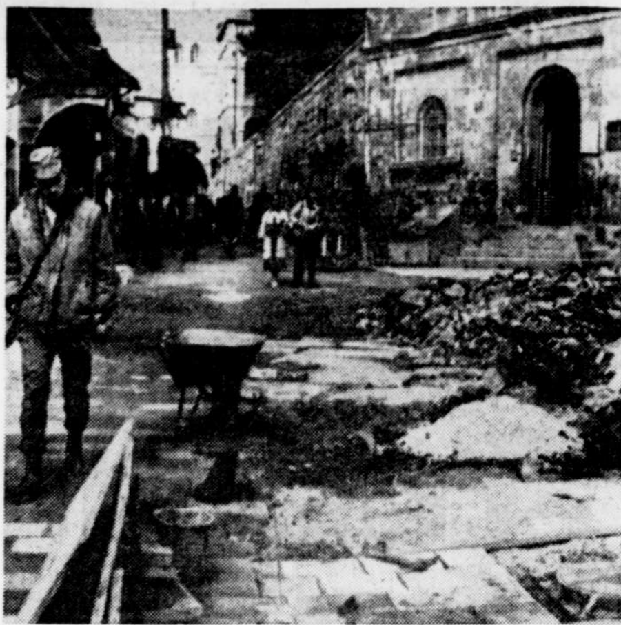
Des travaux de rénovation ont été entrepris sur la Via Dolorosa.
