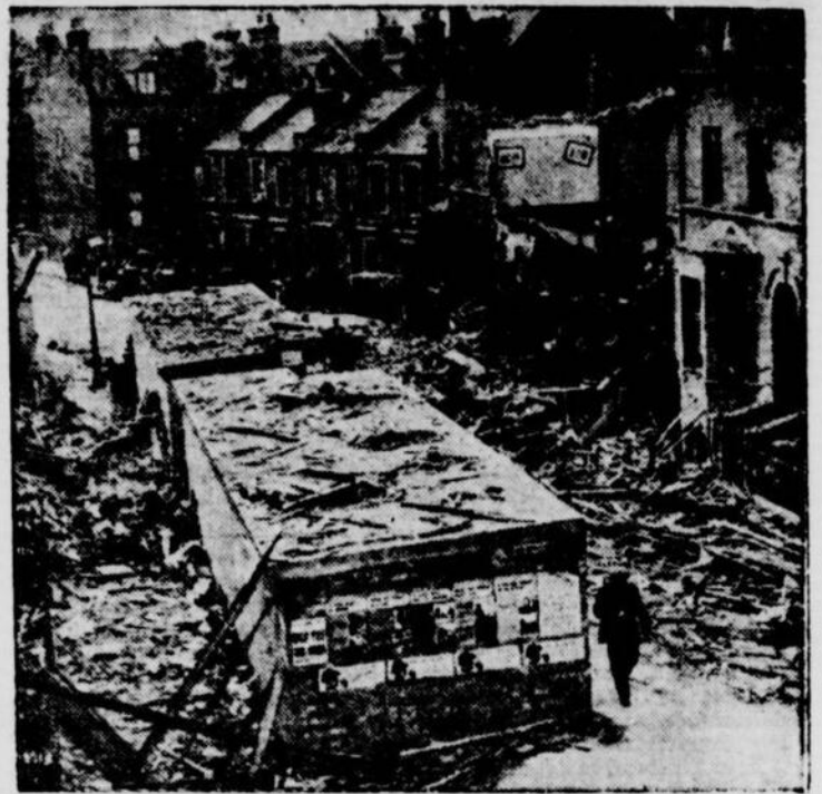
Prise dans une rue du sud de Londres, cette photographie démontre bien la valeur des abris contre les raids aériens construits dans la métropole anglaise. Les maisons, des deux côtés de ces abris, ont été démolies, (à remarquer les cadres encore suspendus sur un mur à droite), mais les abris sont demeurés intacts malgré les bombes.
