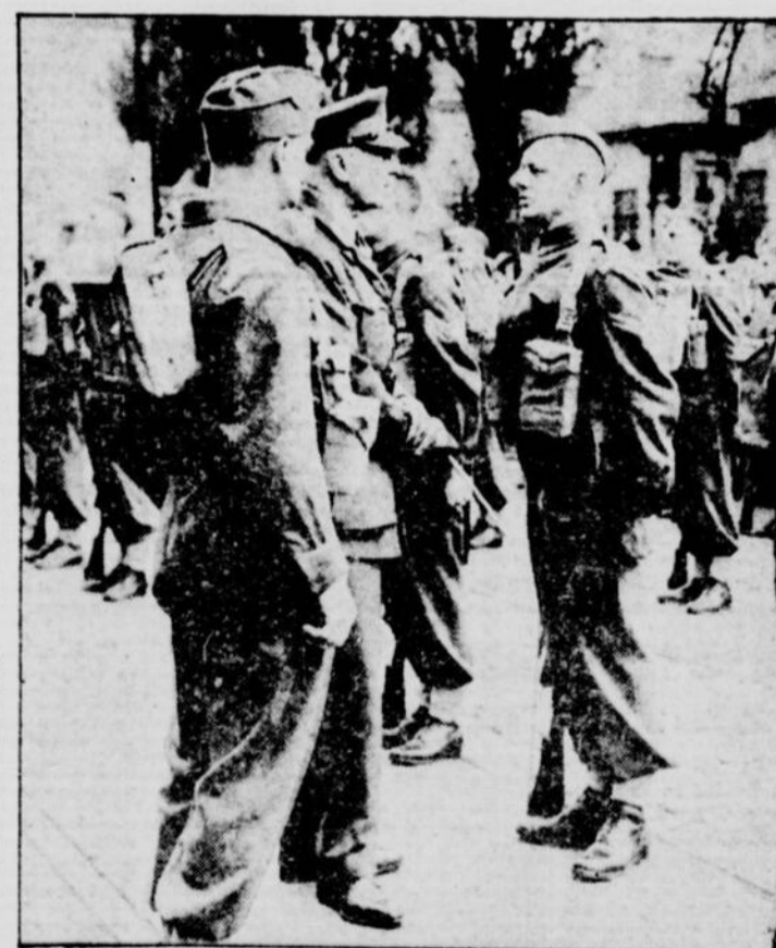
Au cours de sa visite dans la métropole, le gouverneur général a passé en revue des détachements de l'armée active. Havresacs au dos et se tenant raides dans leur uniforme de combat, nos pioupious avaient fort bel air. Le comte d'Athlone a fait cette inspection devant l'historique château de Ramezay qui fut, jadis, témoin de faits d'armes glorieux. Le comte s'est dit impressionné par la belle tenue de nos troupes.
