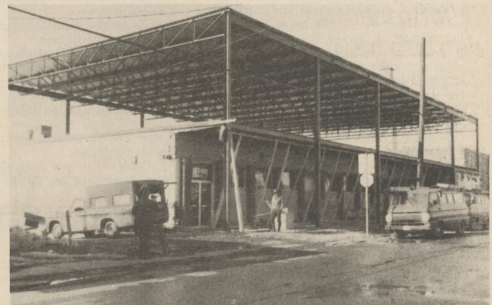
Les travaux progressent
