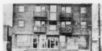
6 - LONGUEUIL - Maison à revenus, 8 logements, chauffage électrique, 3 locaux, pas de vacants, bon placement, site sur Cure Poirier. MLS. Camille Tailleux 468-1000
