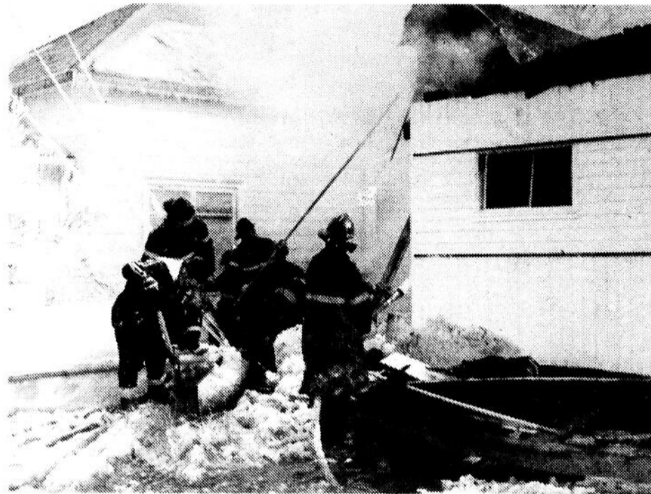
Il est environ 9 h 30 du matin et les sapeurs tentent de maîtriser l'élément destructeur. Dans quelques heures, ce côté sera complètement démoli par l'incendie.
