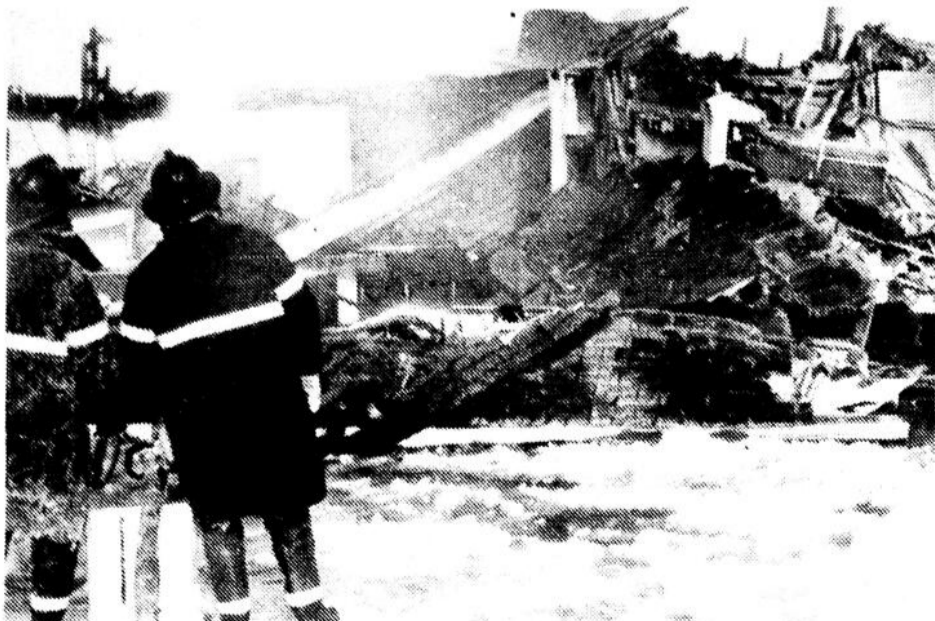
Les pompiers de la ville de Rimouski continuent leur travail. Ils ne peuvent être tenus responsable de la perte complète du restaurant.
