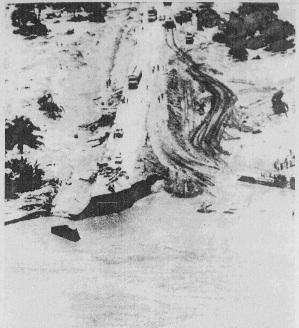
PLUS DE PONT — Une vue aérienne montre tout ce qui reste du pont enjambant la rivière Choloma, près de Tegucigalpa. Après le passage de Fifi, une boue d'eau et de débris a tout emporté sur son passage. (PC Téléphoto)
