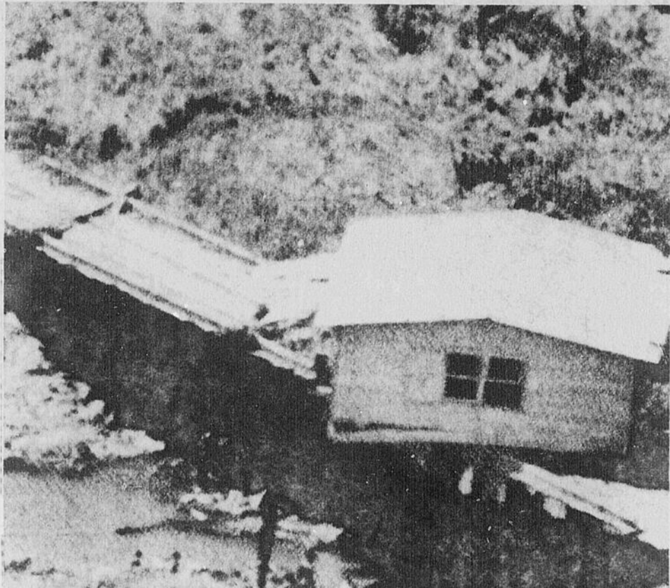
VALLÉE DE L'AGUAN — Cette maison a été complètement déplacée de son terrain pour être entraînée dans une mer de boue et échouer sur un pont lui aussi charrié par Fifi. (PC Téléphoto)
