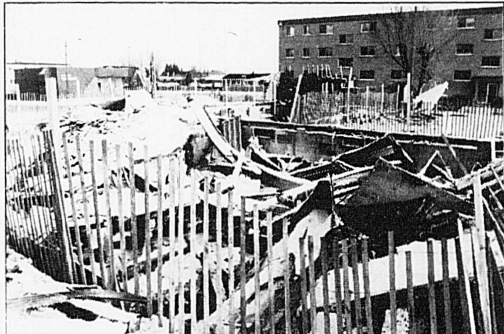
Un des deux incendies d'importance à avoir occupé les pompiers maskoutains, au cours de la dernière semaine, est survenu sur le boulevard Laurier, dans le quartier Douville, jeudi soir dernier. L'ancien bar Le Palais Bleu, qui était devenu un commerce de vente de véhicules, a été totalement rasé par un incendie dont l'origine est encore inconnue.
