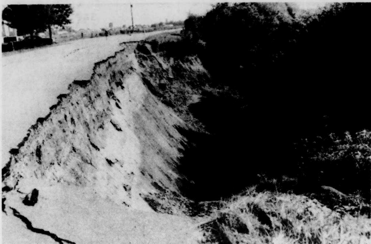
La photo du haut nous montre bien le gouffre qui a été causé par un glissement de terrain dans le rang Rivière-Sud-Ouest en paroisse de Maskinongé, tout près de la rivière à cet endroit. On craint également que d'autres parties de la route s'effondrent dans les prochains jours, surtout si les pluies se font abondantes. (Photo Lapointe)
