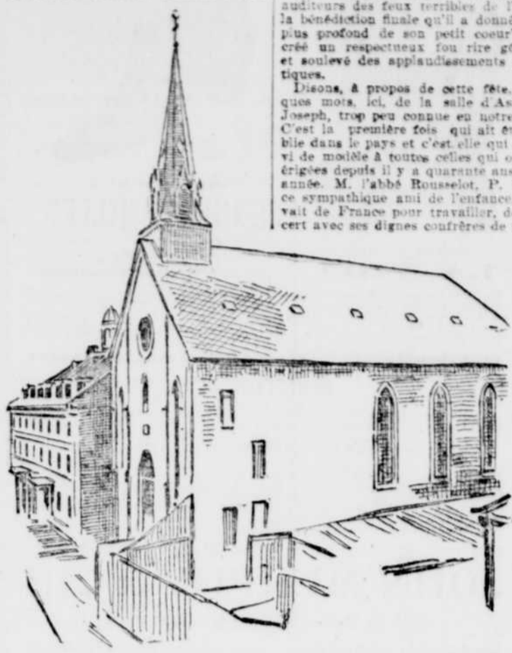
ÉGLISE PAROISSIALE DE SAINT-JOSEPH ET ORPHELINE DES SOEURS GRISSES...
