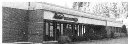
Usine de Beauceville
