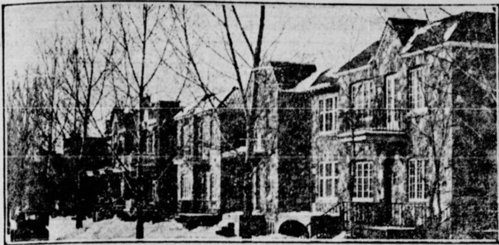
Une vue des magnifiques résidences qui font l'admiration des passants et l'orgueil des citoyens. d'Ahuntsic. On voit ici le côté ouest de la Grande-Allée. (Photo la Patrie)
