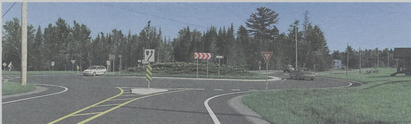
Le carrefour giratoire fera le lien entre deux rues et deux avenues au nord de la municipalité. (Photo Gracieuseté)
