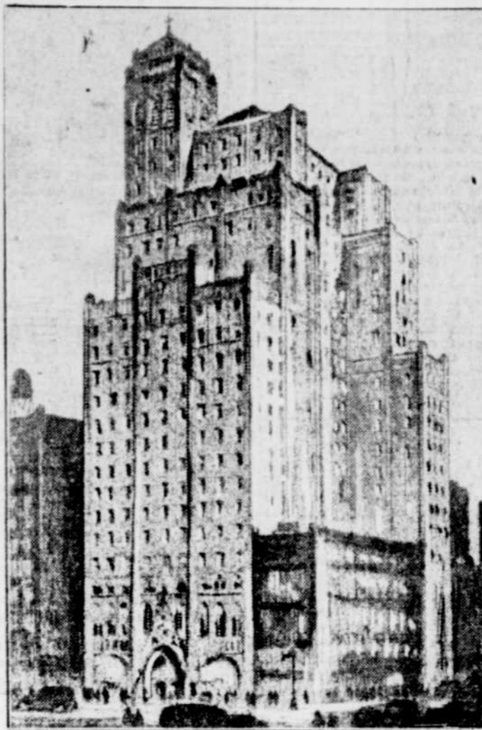
Les membres de la Manhattan Congregational Church, New-York, vont contempler une église-gratte-ciel de 23 étages de style gothique. Elle coûtera environ trois millions de dollars. L'église sera au centre de l'étage principal, le deuxième. La tour illuminée sera surmontée d'une croix.
