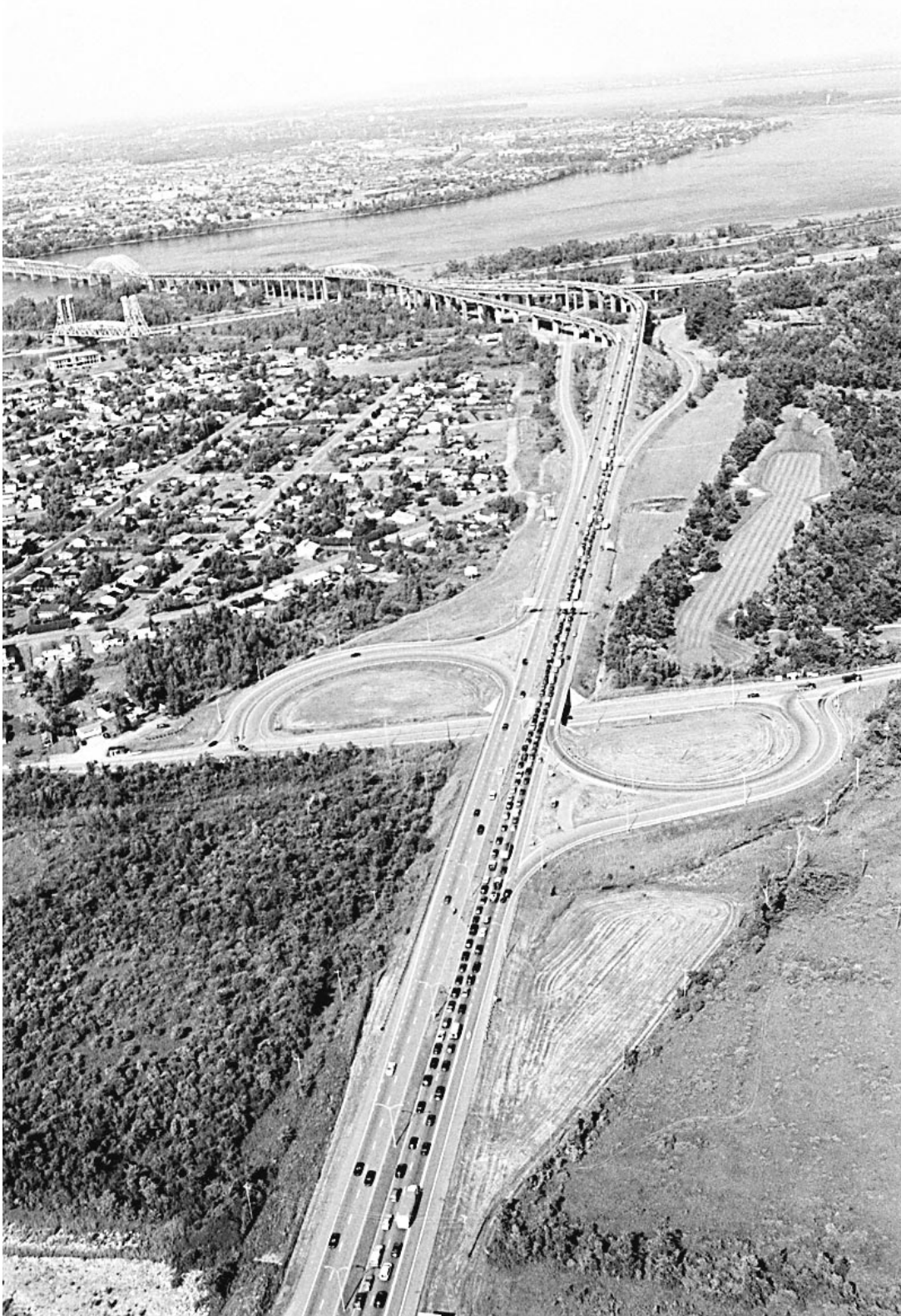
À cet endroit, la route 138 a quatre voies. Au départ, le ministère devait ajouter une voie réservée pour les autobus, au coût de 6,2 millions pour quatre kilomètres. Mais le conseil de bande a exigé une sixième voie. Les travaux coûteront donc presque sept millions par kilomètre, en comptant les honoraires professionnels.
