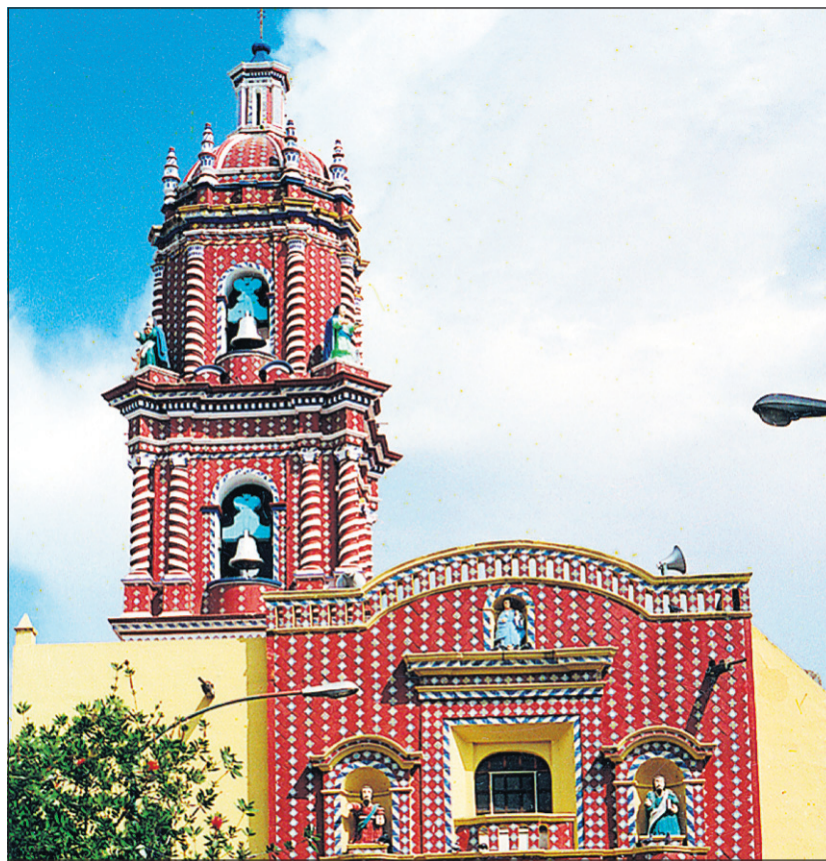
Dans l'église Santa Maria Tonantzintla, les voûtes, les colonnes et tous les murs sont tapissés de motifs sculptés exubérants dont le relief est très prononcé.
