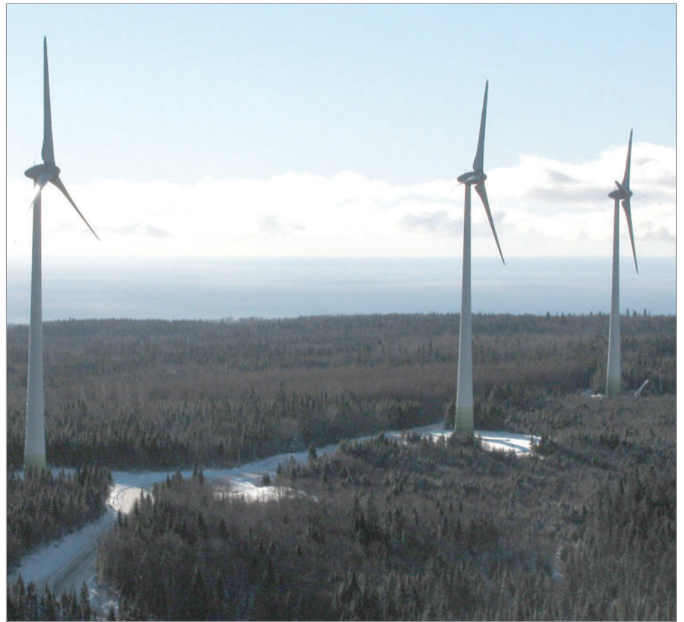
Le parc éolien de TransAlta a une puissance de 68 MW générée par 33 éoliennes de type Enercon. PHOTO COURTOISIE.
