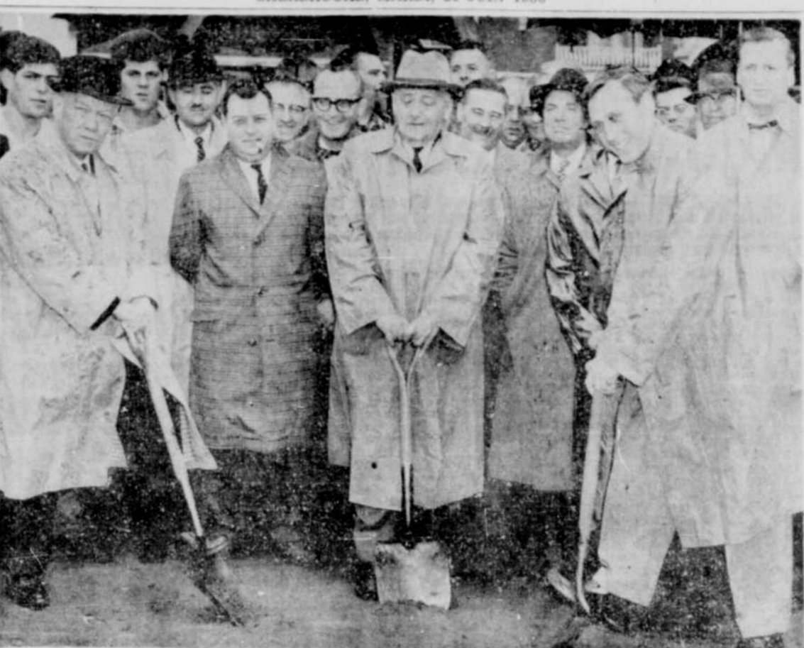
Début de construction — La construction de l'édifice provincial a débuté hier à Drummondville. On voit ici au moment de la levée de la première pelletée de terre MM. Robert Bernard, député sor-
