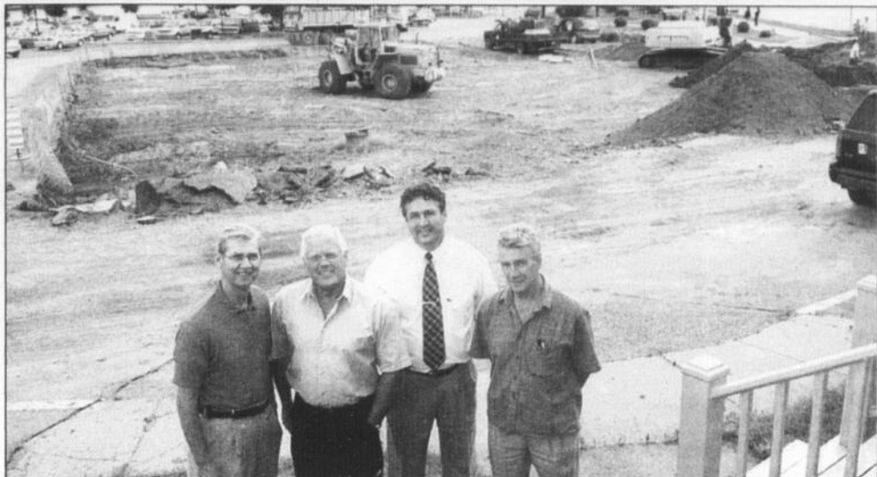
PLACE DU QUAI - Les conseillers Marc-André Gagnon, Serge Simard, le directeur Denis Coulombe et le conseiller Jean-Eudes Simard se sont rendus jeter un coup d'oeil aux travaux de la place du quai. (Photo Rocket Lavoie)
