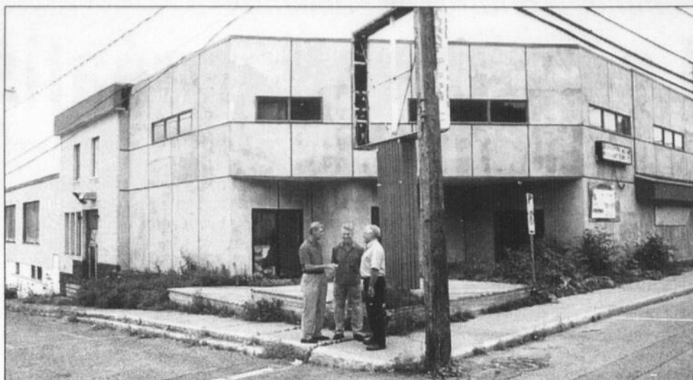
DÉMOLITION - Les conseillers Marc-André Gagnon, Jean-Eudes Simard et Serge Simard se disent fort satisfaits de la démolition imminente de cet ancien édifice commercial. (Photo Rocket Lavoie)
