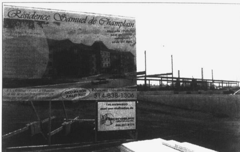
Le chantier de la Résidence Samuel-de-Champlain alimentera les statistiques dans la catégorie des logements collectifs.
