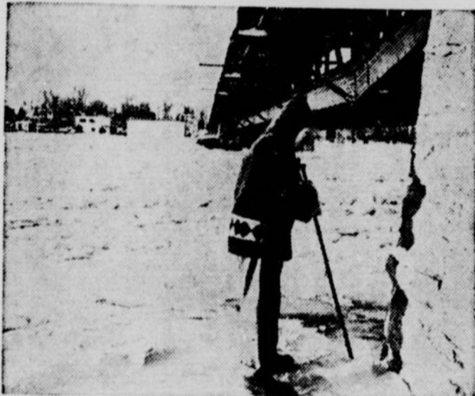
Un employé de l'Hydro-Québec vérifie l'épaisseur de la glace sous le pont de chemin de fer à Bordeaux.
