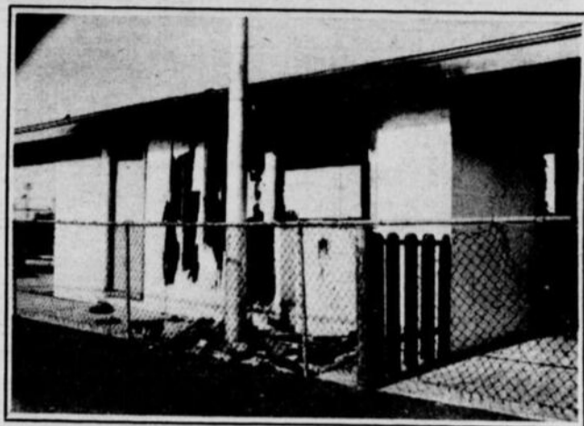
Le vandalisme a atteint un rare degré de paroxysme à Verdun ainsi qu'on peut en juger par cet édifice aux murs littéralement démolis.
