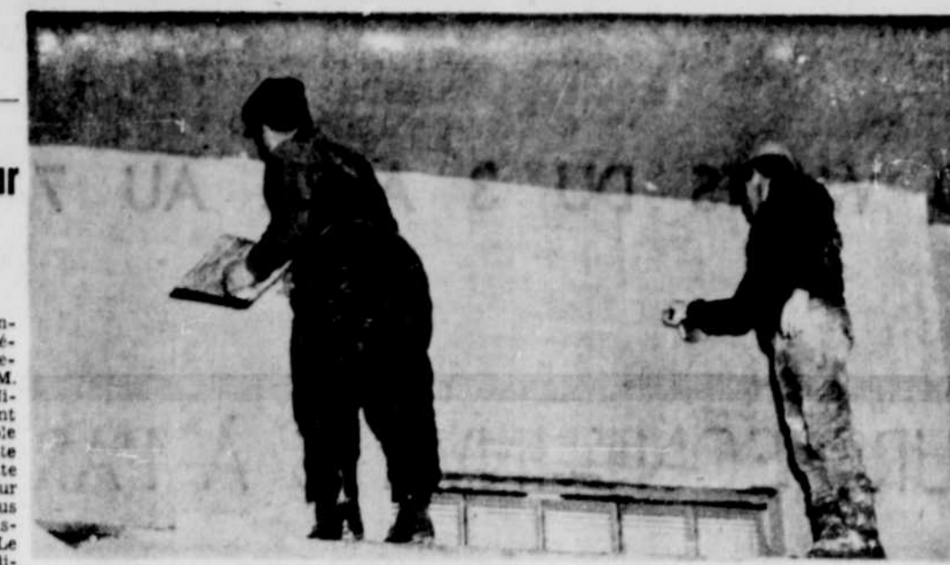
DEUX OUVRIERS S'AFFAIRENT à donner une dernière touche au fini intérieur de la caserne de pompiers de Saint-Louis-de-France. Il ne restera plus qu'à recevoir le camion qui occupera la moitié de l'édifice, l'autre partie servira de salle paroissiale.
