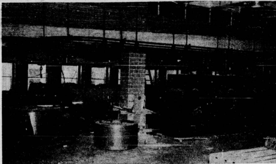
LA BUANDERIE. — On peut facilement imaginer ce que doit contenir une buanderie qui doit desservir un hôpital pour enfants de 860 lits et son personnel. Les services de la buanderie occuperont des locaux d'une superficie d'environ 13,000 pieds carrés. Les machines pour le lavage, désinfection, repassage, séchage et transport du linge sont les plus économiques et les plus efficaces possibles. On distingue ici quelques laveuses, essoreuses et séchoirs en voie d'installation au nouvel Hôpital Sainte-Justine.
