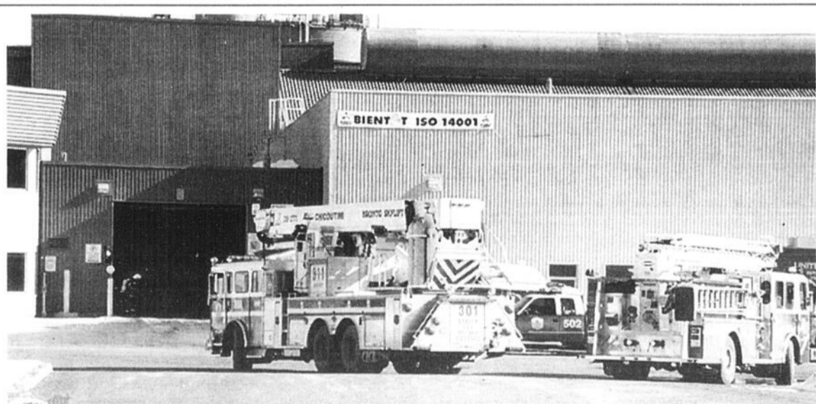
INTERVENTION - Un début d'incendie dans un pont roulant à l'usine Alcan de Laterrière a nécessité l'intervention d'une douzaine de pompiers de Chicoutimi.
