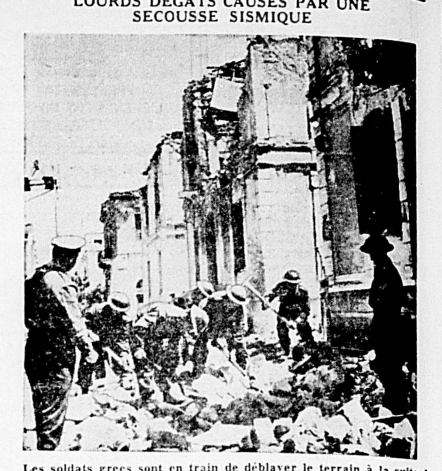
Les soldats grecs sont en train de déblayer le terrain à la suite de la démolition de centaines de maisons causée par une secousse sismique qui a duré plusieurs minutes. Dix personnes ont perdu la vie et des centaines d'autres ont subi des blessures au cours de cette hec-tombe. Les dommages s'élèvent à des millions de dollars. (Photo P.C.)
