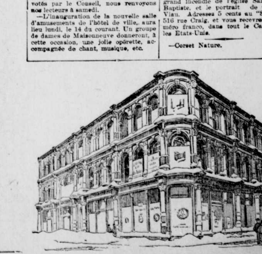
LE BLOC BARRON TEL QU'IL EST DEPUIS L'INCENDIE.—Photographie Laprés et Lavergne, rue Saint-Denis, coin de la rue Ontario.
