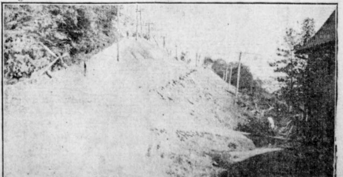
Une des côtes de sable de Les Ecureuils dont on a diminué la pente de 12 p.c. à 5 m.c. C'est une partie des plus intéressantes de la section de Québec de la route nationale.
