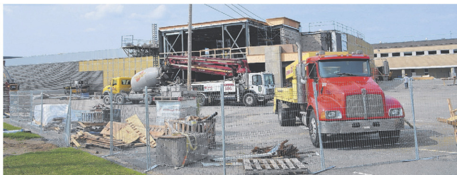
Le chantier respecte l'échéancier. (Photo TC Media - Carol Isabel)
